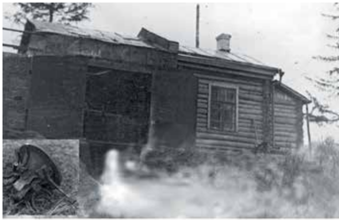
1948 г. Стенд в Алабино для испытаний ЖРД. Слева в углу – снимок створенного сопла
