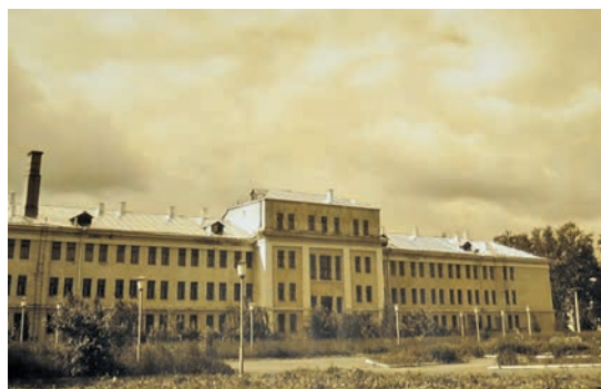
Учебный корпус Военно-инженерного училища (1936–1937 постройки). Позднее – Главный корпус НИИ-4, Первый центр управления запуском и полетом первого спутника, животных и Ю.А. ГАГАРИНА в космос, а также последующих пусков, до постройки ЦУПа в Королёве
